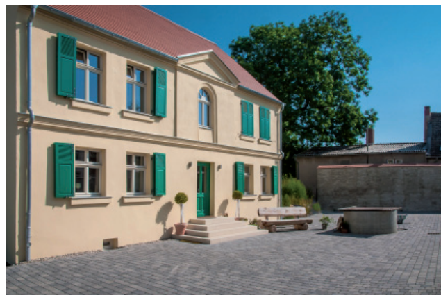
Abb.10 Sanierte Hofanlage Westeregeln; Fotograf: C. Hertel
